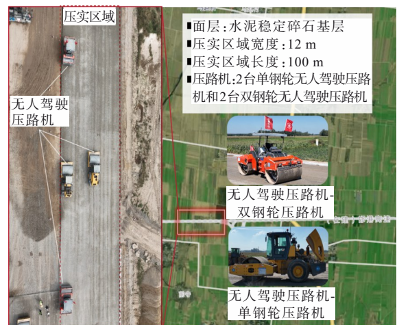
图6 无人驾驶压路机集群作业现场测试
