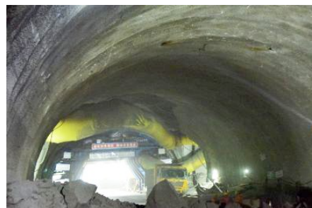
图1 中梁山隧道施工现场
