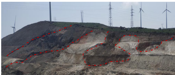
图2 边坡开挖地下水情况
