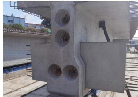
图3 装配式T梁横隔板
