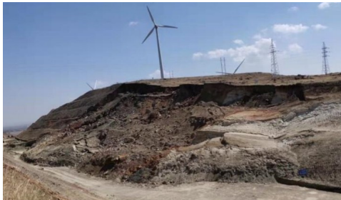
图1 K5+300~K5+350坍塌现场图 Figure 1 K5+300~K5+350 collapse site map
