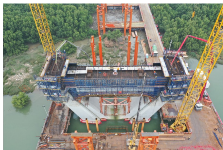
图10 装配式施工平台与钢栈桥
