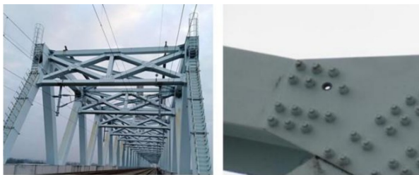
图1 钢桁梁桥螺栓脱落
