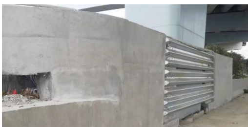
(b) 第一重船形加高构件和第二重钢板组合防护
