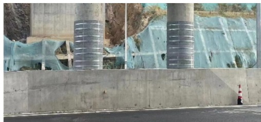
(a) 第一重混凝土护栏和第二重泡沫铝组合防护
