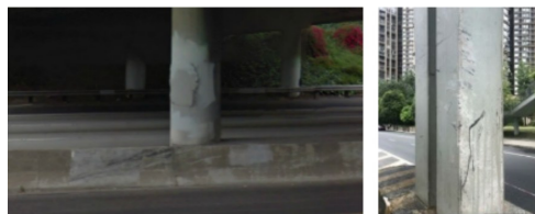
(b) 车辆外倾碰撞桥墩,导致桥墩表面受损
