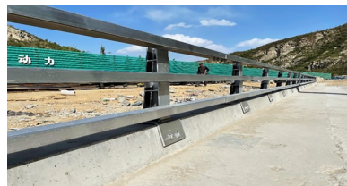
图12 护栏安装样品
