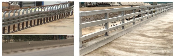
(a) 波形梁护栏和混凝土护栏 (b) 梁柱一体式型钢护栏
