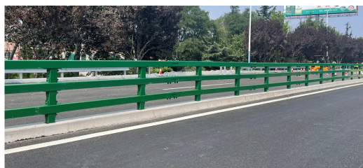
图 17 节地美观型 SAm 级中央分隔带梁柱一体式型钢护栏工程应用
