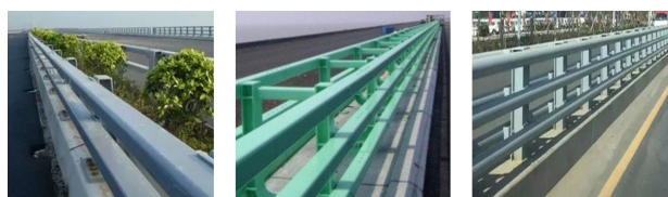
(a) 双道分设型 (b) 双道组合型 (c) 单道双梁组合型
