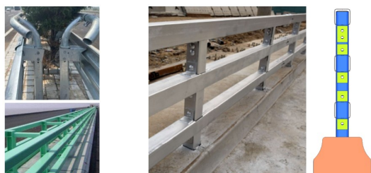
(a) 双道设置的中分带护栏 (b) 梁柱一体式型钢护栏
