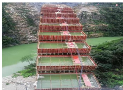
图8 钢拱架水箱预压加载
