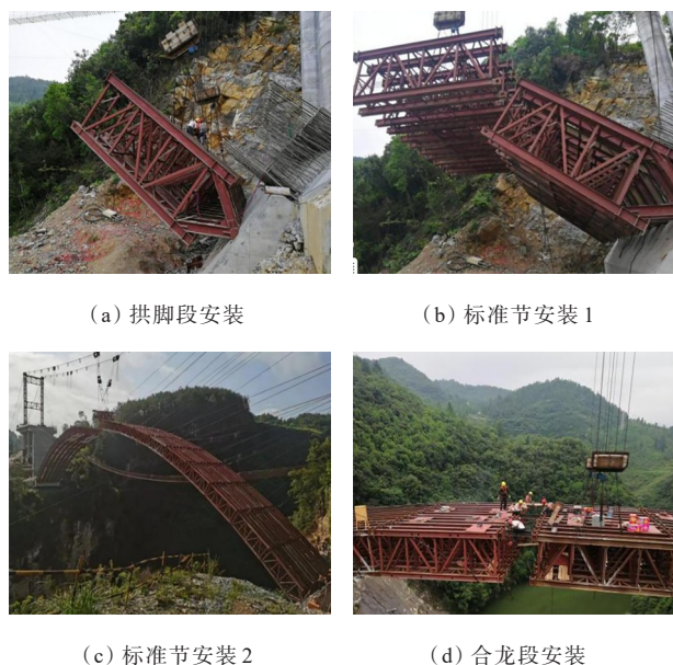
图7 拱架节段拼装过程
