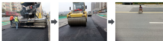
图6 试验段路面摊铺、碾压及3年后现场观测
