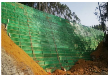
图4 柔性挡墙现场图
