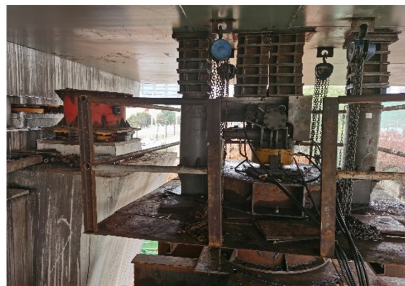
图8 落梁吊挂系统
