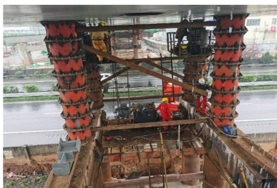
图7 落梁墩和置换墩
