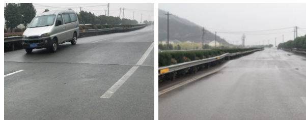
图6 原软基段路基沉降病害图
