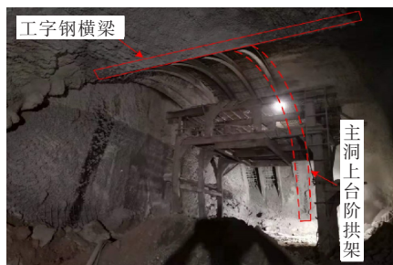
图8 交叉段正洞钢架施工现场
