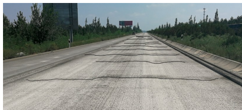
图 4 K394 基层横缝缝口松散
