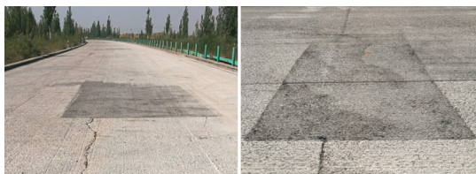
图5 沥青稳定碎石换填基层效果图
