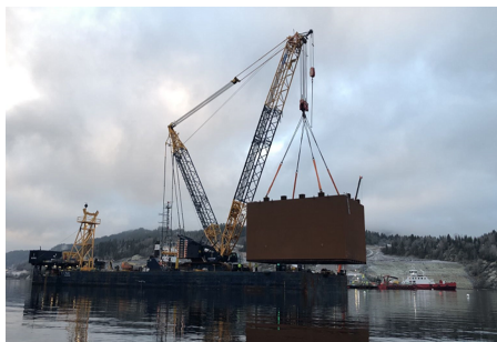
图 17 钢围堰整体下放施工现场
