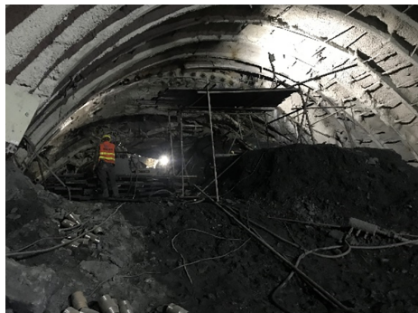
图2 掌子面失稳导致拱顶坍塌
