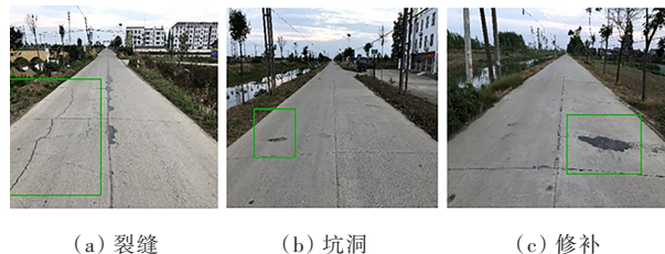
图 5 水泥路面破损
