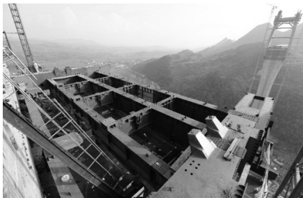
图 8 1# 块工况下挂篮安装完成
