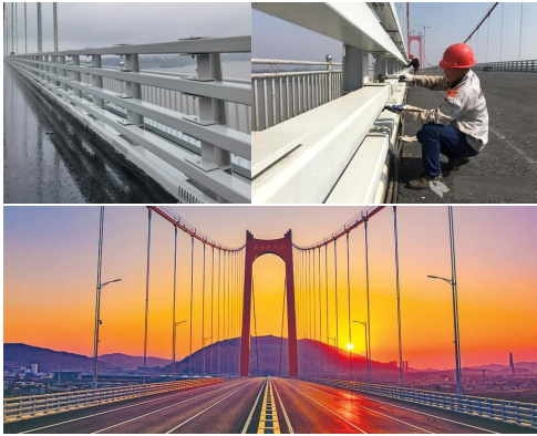
图 11 HA 级梁柱式钢护栏在棋盘洲长江公路大桥上的应用照片
