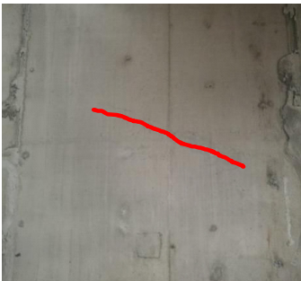
图 1 箱梁裂缝
