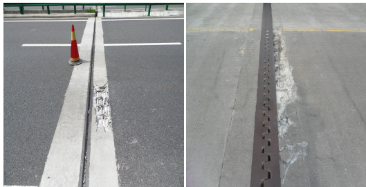
图1 桥梁伸缩缝混凝土的损坏
