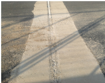
图 10 渭玉高速公路关中环线分离式立交伸缩缝
