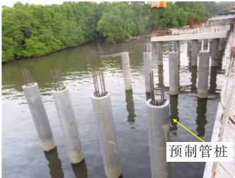
图 3 预制桩柱式桥墩
