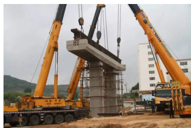
(b) 履带吊安装盖梁
