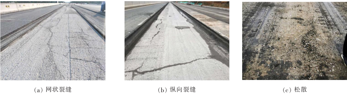
图 4 第 2 车道路面结构内部典型病害
