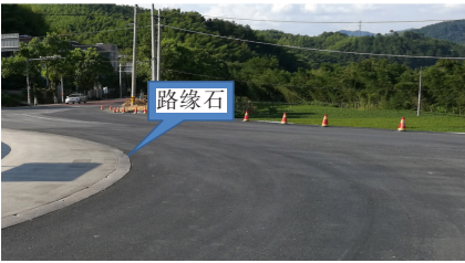
图 7 削磨平整后的路缘石
