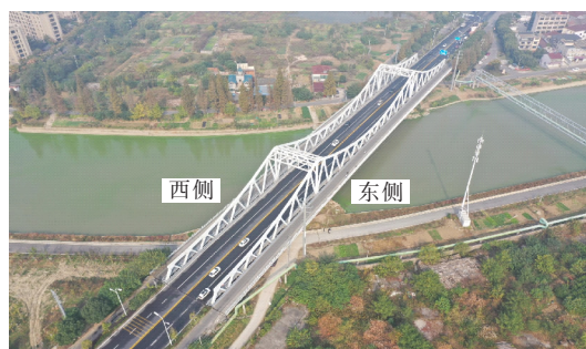
图 1 钢桁架桥上部结构
