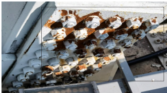
图 5 节点螺栓锈蚀程度严重
