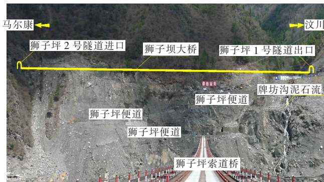
图 3 狮子坝大桥桥位地形地貌和施工现场图
