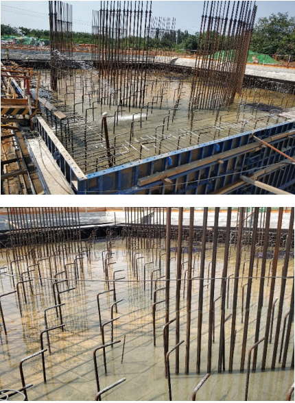
图 4 转体桥承台的蓄水养护
