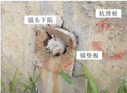
图 3 锚垫板及锚头下陷
