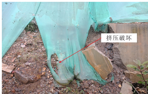
图 1 一级矮脚墙局部挤压破坏
