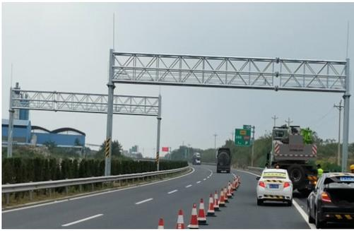
图 6 高速公路智慧行车 ETC 门架系统实景照片
