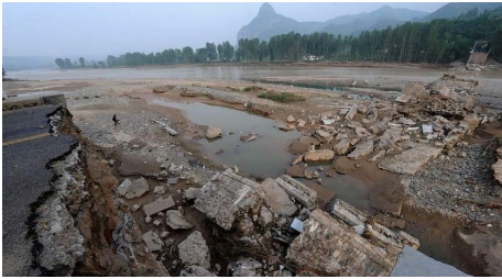
图 4 栾川汤营大桥塌陷现场
