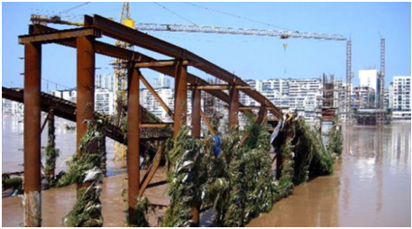
图 2 四川 G318 线渠江二桥被冲毁留下的支架
