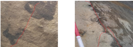
图 2 隧道裂缝情况
