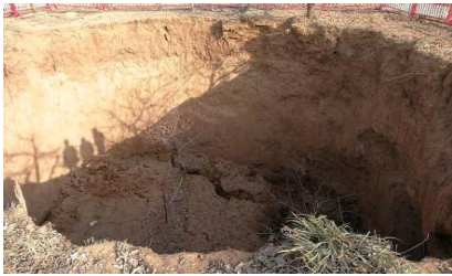
图 4 ZK87+088~ZK87+100 上方地表陷坑
