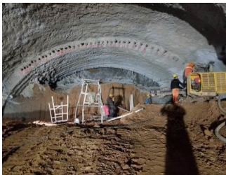
图 7 洞内管棚施工
