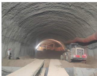
图8 ZK87+080~ZK87+102紧急停车带处治施工照片
