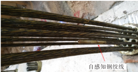
图 3 自感知钢绞线埋设
