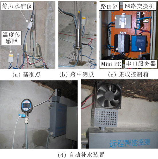
图 6 挠度监测系统主要装置
