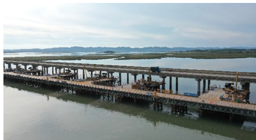
图11 现场钢栈桥图
