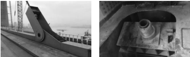
图 6 耳板式索梁锚固(塔端锚头张拉)
