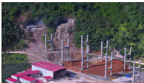
图1 桥隧相接部位
