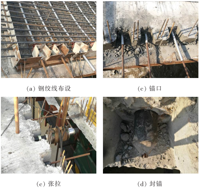
图 5 大直径横向预应力钢束施工过程图片
