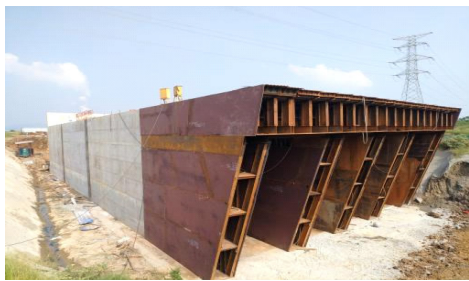
图 4 预制框架桥实体图
