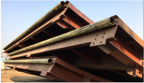
图3 吊箱围堰侧板锁口构造
