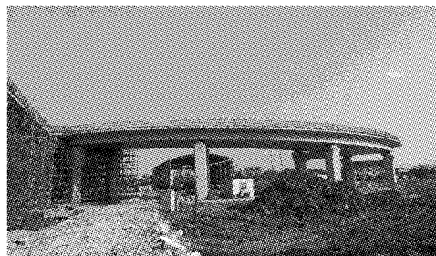
图 1 研究梁段的支架搭设图
