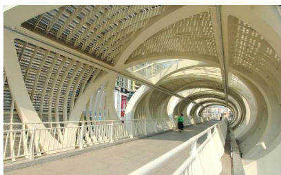
(c) 螺旋钢桁架方案(主桁变换为螺旋形)
