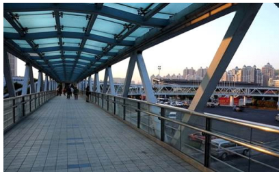
(a) 平行弦杆桁架方案(两片主桁)
