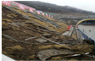
图1 边坡浅表层滑塌
