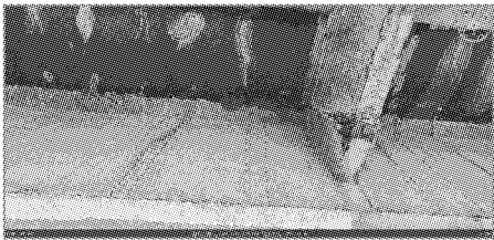
图 7 横隔板混凝土剥落标记
