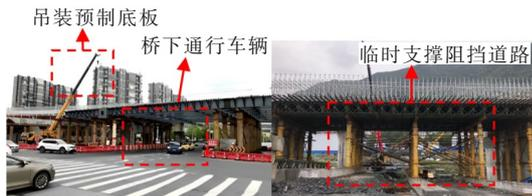
图1 二次受力叠合板与现浇板施工阶段对比
