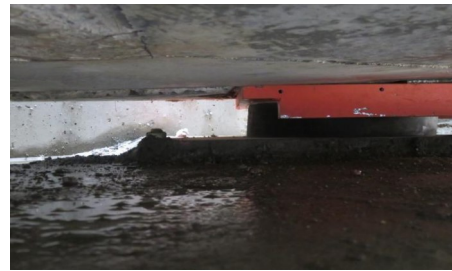
图8 支座安装没有考虑预偏量,不能满足变形要求
