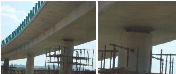
图5 单向安装滑动方向错误
