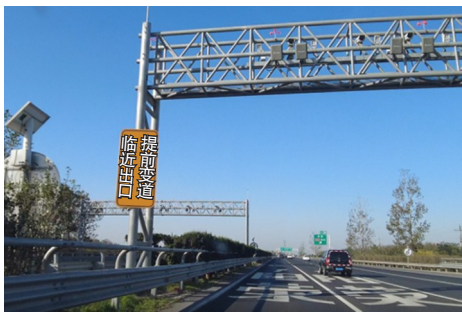
图8 附着于门架左侧立柱上的告示标志
