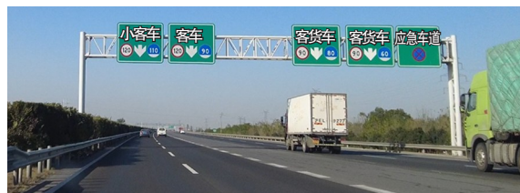
图4 车道转换带上方无对应限速标志
